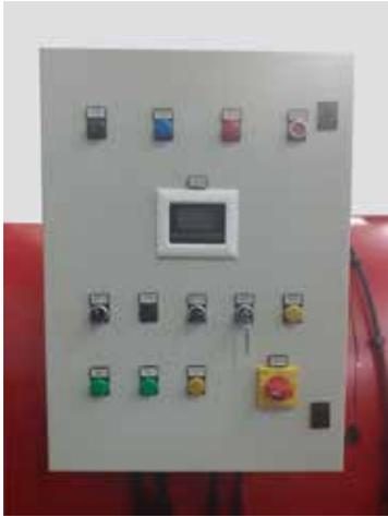
I **KIT 24 e 72 ore** rendono possibile esercire un generatore di vapore o un generatore di acqua surriscaldata (solo 72 ore) senza la supervisione del conduttore patentato per 24 o 72 ore e ottenere così l'esonero parziale dalla sorveglianza continua.
